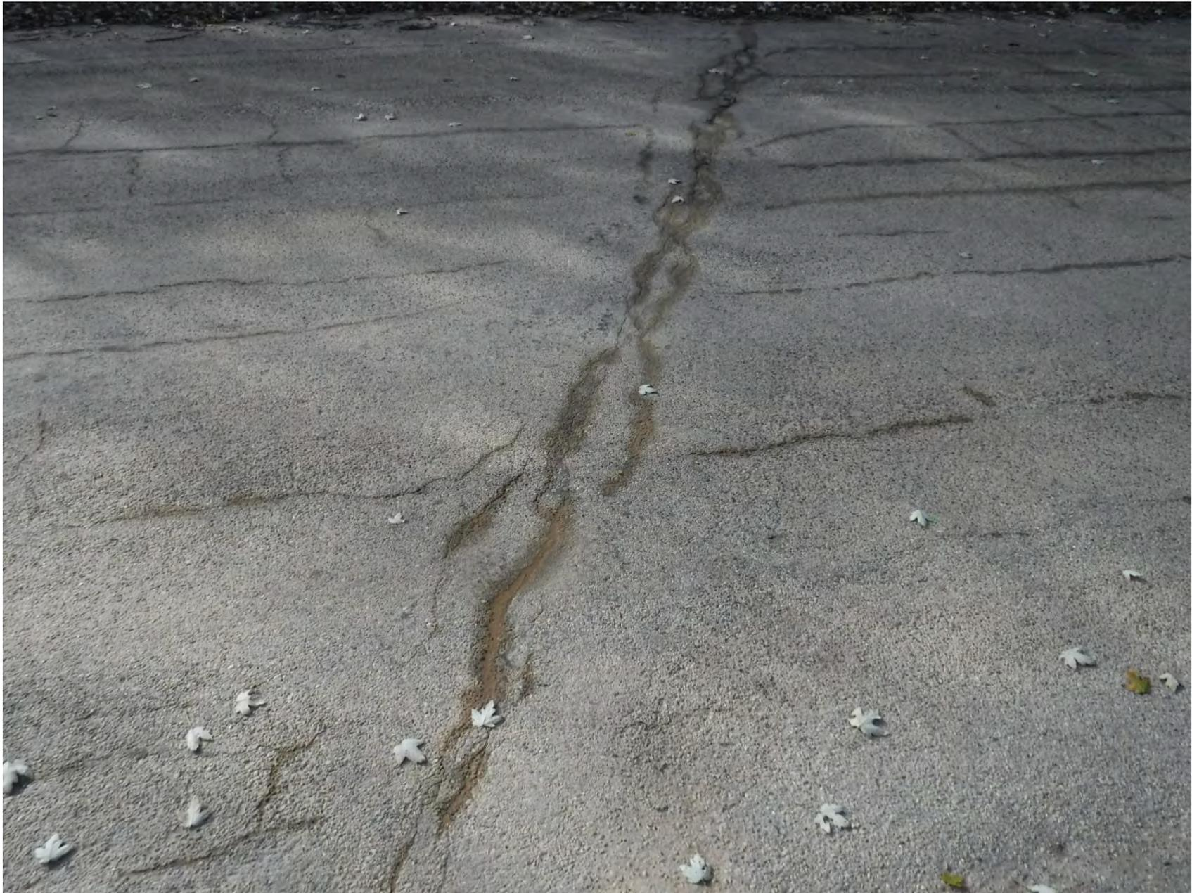
TRANSVERSE CRACKS IN HMA SURFACE OVER PIER
